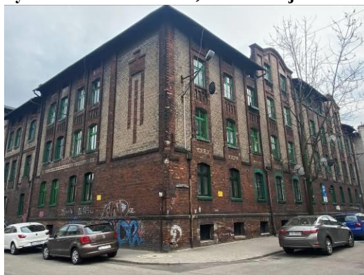
Fot. 51 Widok na budynek przy ul. Damrota 10-12
