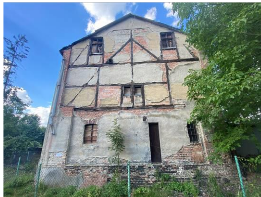
Fot. 90 Widok na budynek młyna
