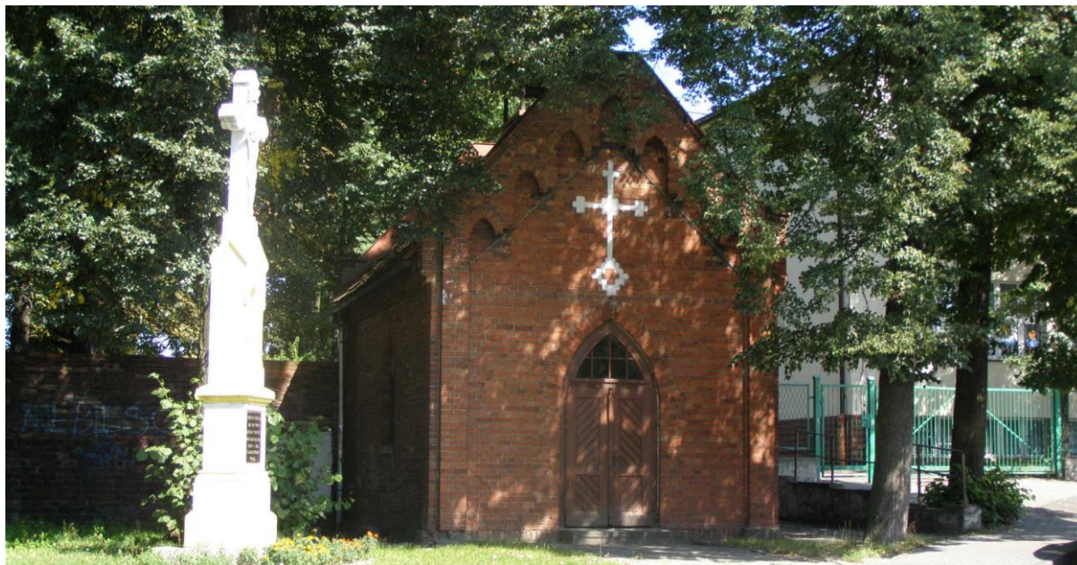
Widok na krzyż murowany (a) i kaplicę kubaturową (b)
