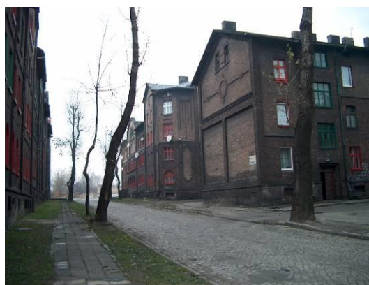
Fot. 38 Widok na budynki przy ul. Podgórza
