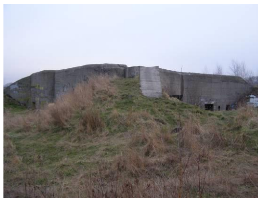
Fot. 76 Widok na schron bojowy BN-3
