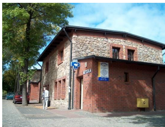
Fot. 30 Widok na kolonię "Ficinus"
