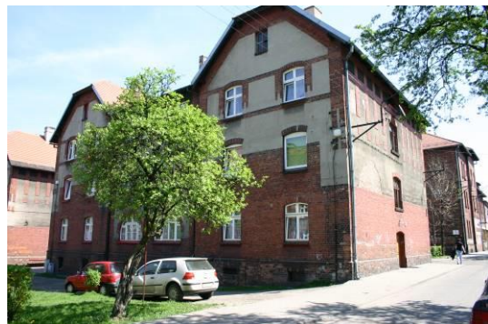
Fot. 46 Widok na budynki przy ul. Kolbego
