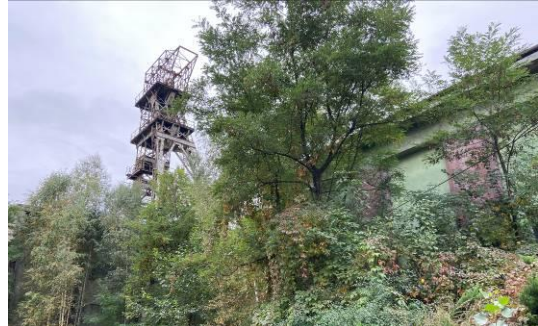
Fot. 85 Widok na zespół zabudowy Szybu "Mikołaj"
