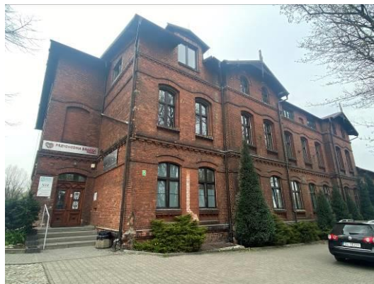
Fot. 100 Widok na budynek przy ul. Pokoju 13
