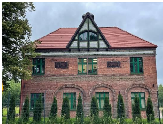
Fot. 93 Widok na Bramę II
