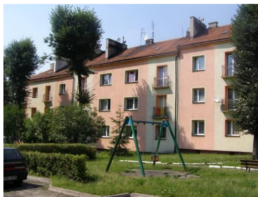
Fot. 40 Widok na budynek położony przy ul. Dunajewskiego 15-15b
