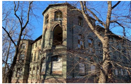
Fot. 61 Widok na budynek dawnego szpitala przy ul. 1-go Maja 279
