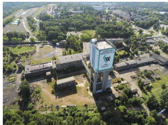
Fot. 97 Widok ogólny na Kopalnię "Pokój"
