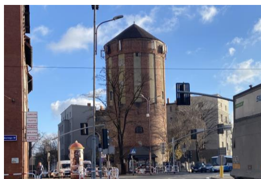
Fot. 81 Widok na wieżę ciśnień w Nowym Bytomiu
