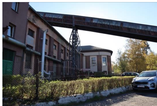
Fot. 86 Widok na fragment elektrociepłowni "Mikołaj"
