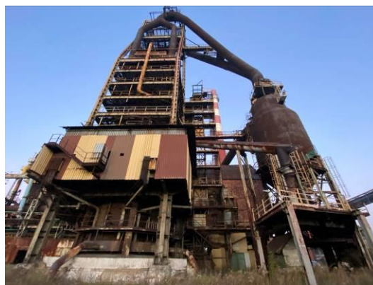
Fot. 92 Widok na Wielki Piec "A"
