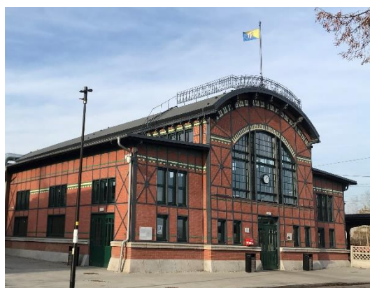
Fot. 68 Widok na dworzec przy ul. Dworcowej 33
