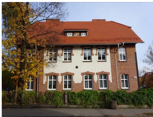
Fot. 33 Widok na budynek przy ul. Niedzieli 22
