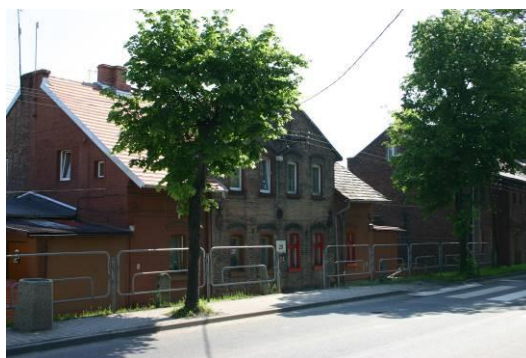
Fot. 44 Widok na budynki przy ul. Szczęść Boże
