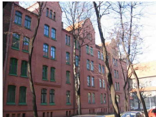
Fot. 34 Widok na kamienice przy ul. Wojska Polskiego
