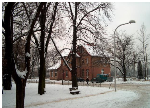
Fot. 87 Widok na dworzec zespołu stacyjnego
