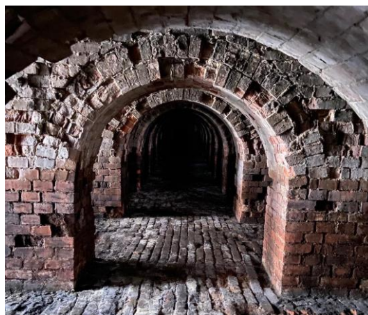
Fot. 88 Widok na wnętrze baterii koksowniczych
