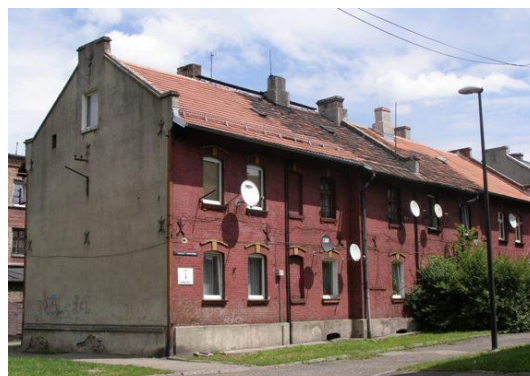
Fot. 37 Widok na budynek przy ul. Głowackiego 1
